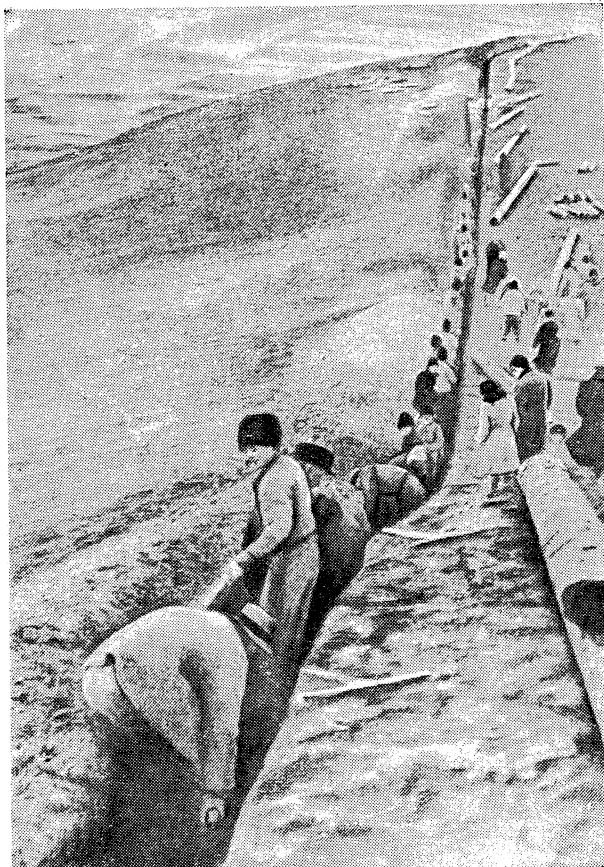
На прокладке газопровода Чеанул-Маре — Клуж. Общий вид работ.
